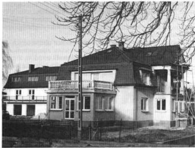
Remontowany budynek przy ul. 9 Listopada.
