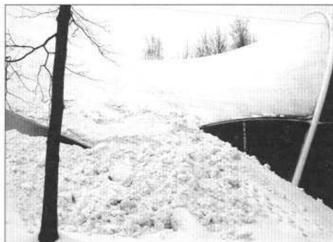
Dach amfiteatru nie uległ śniegowi.
