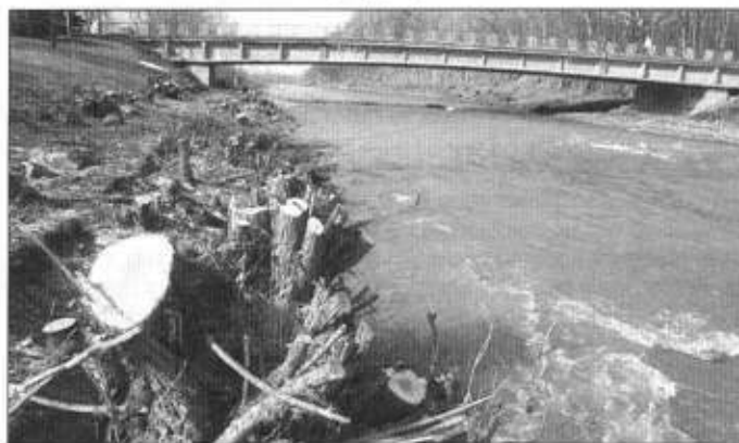
Przejażdżono się nad Wisłą. Przy prowadzonym remoncie rzeki wycinane są gęste krzaki wikliny, które niestety odrosną. Fot. W. Suchta
