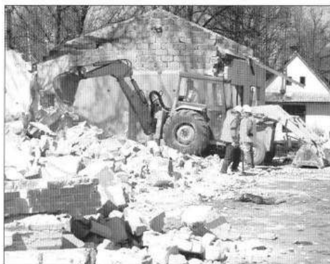
Rozbiórka budynków na trasie obwodnicy.
