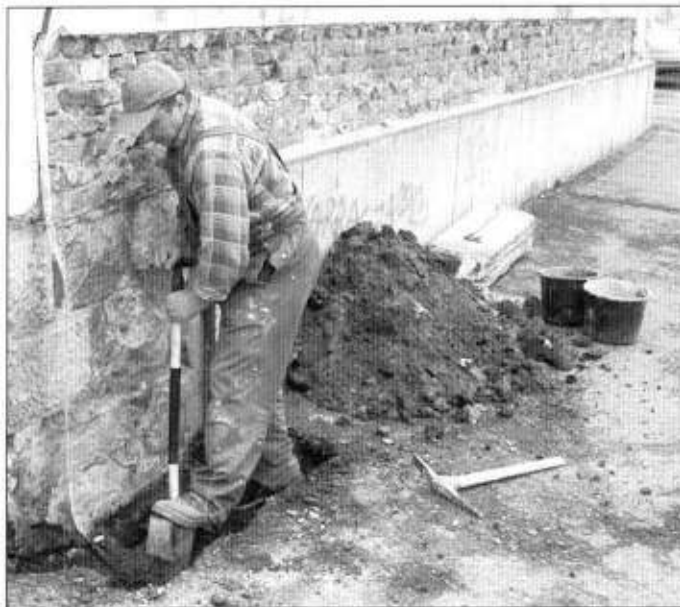
Rozpoczęły się roboty związane z osuszaniem zawilgoconych ścian budynku Biblioteki przy rynku. Fot. W. Suchta
