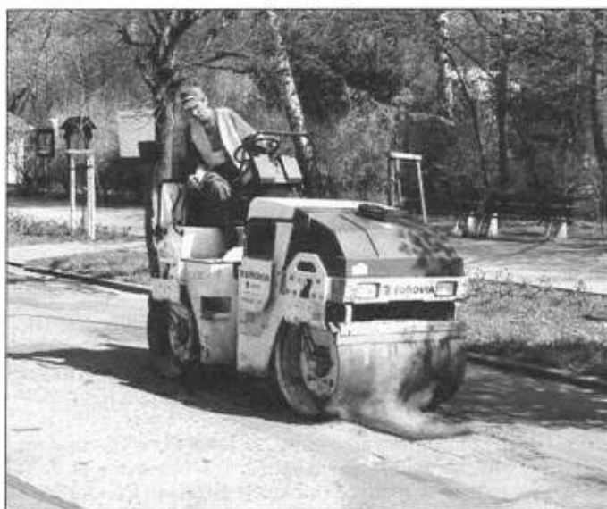
Trwa poziomowe latanie jezdni.
