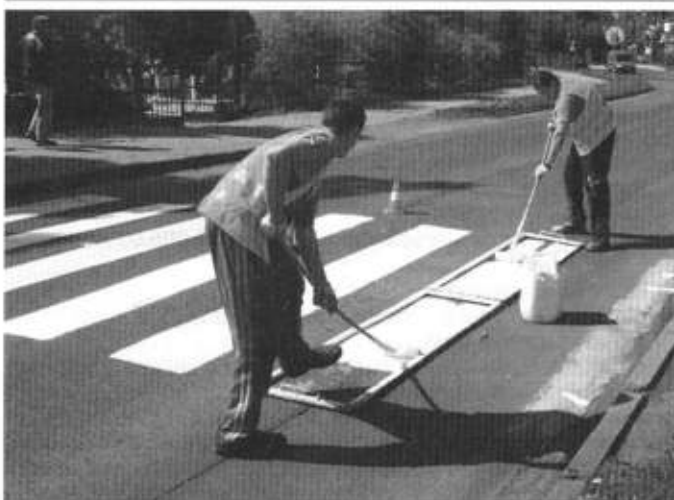
Poziome znakowanie ulic.
