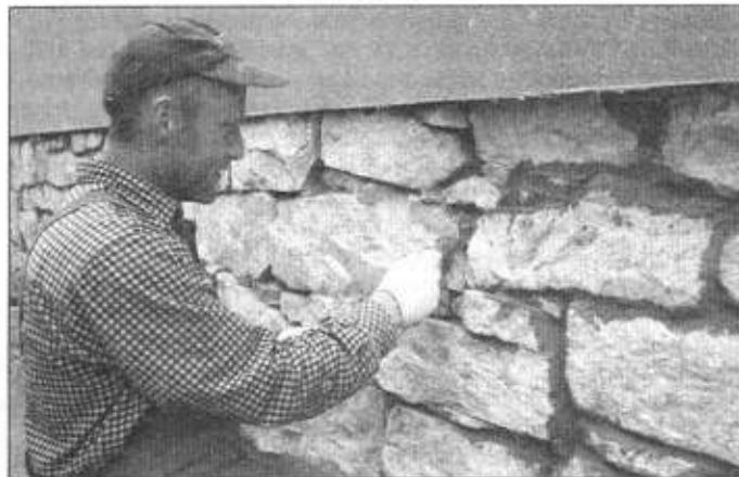
Trwają prace wykończeniowe osuszenia budynku, w którym mieści się Miejska Biblioteka Publiczna. Fot. W. Suchta
