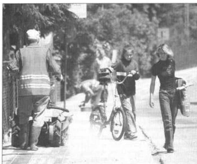
Najpierw wycięto drzewa i mieszkańcy zastanawiali się po co. Na ulicy Grażyńskiego wybudowano nowy chodnik. Na zdjęciu widać ostatnie prace porządkowe. Fot. W. Suchta
