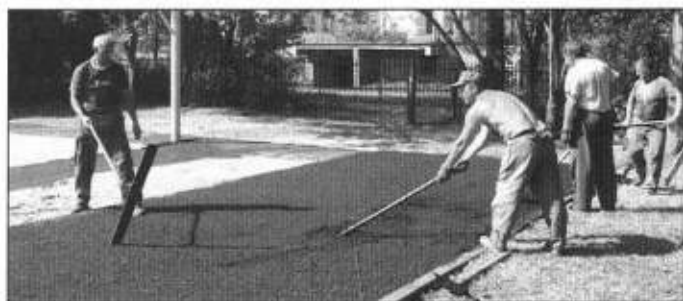
Położono nowy asfalt na boisku.
