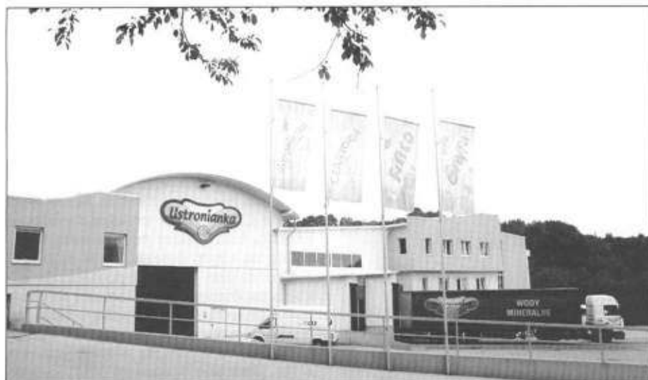
Zakład „Ustronianki” na Jelenicy.
