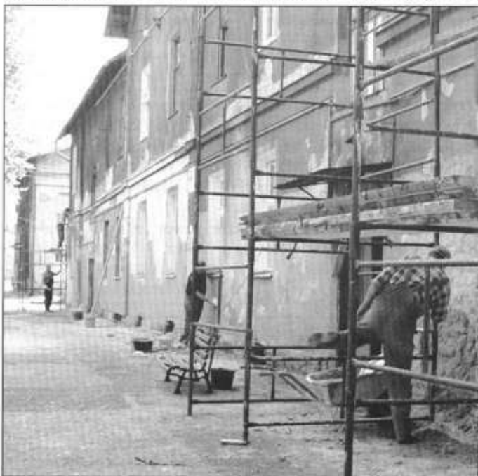
Trwa remont Wielkich Domów.
