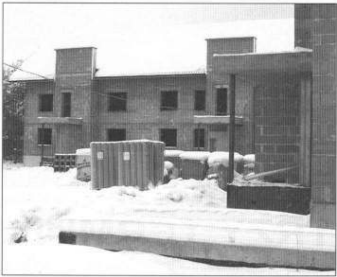
Powstają budynki nowego osiedla TBS.
