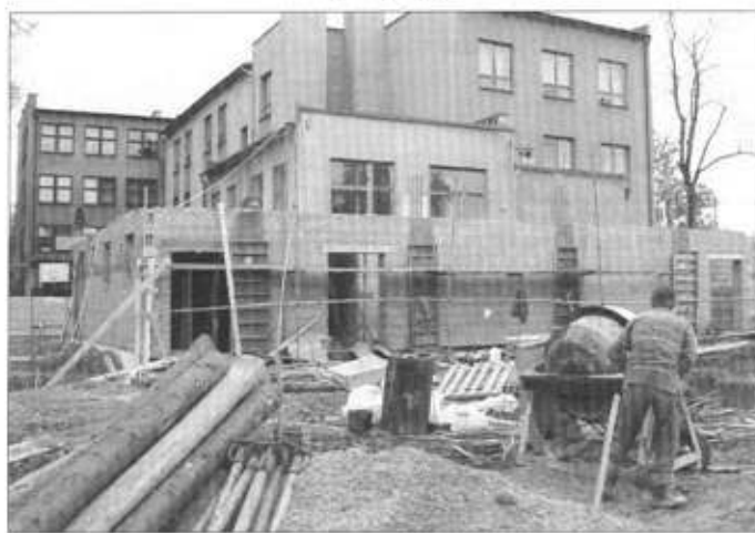
Trwa budowa sali gimnastycznej w Nierodzimiu.
