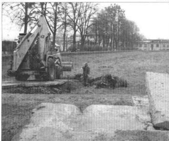
Rozpoczęły się roboty na stawie kajakowym. Na miejscu pojawiła się koparka i układa betonowe płyty, po których będzie mogła jeździć wybierając muł.
