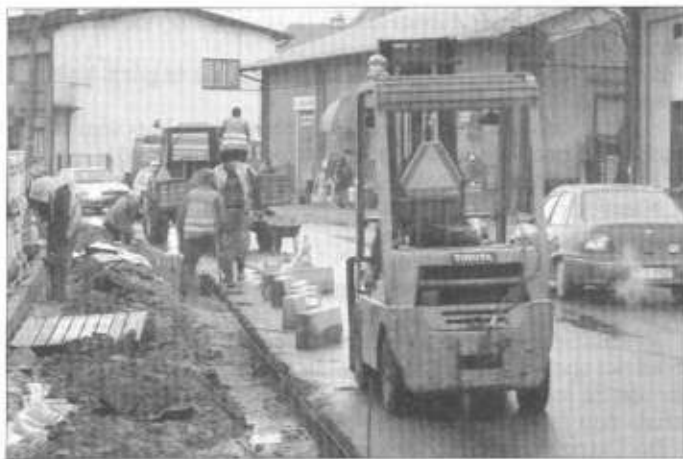
Trwa remont chodnika przy ul. Daszyńskiego.
