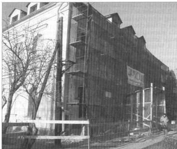
Trwa odnawianie elewacji budynku poczty.
