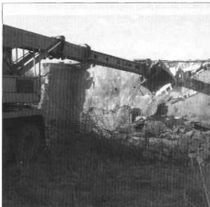
Zniknęły baraki na Zawodziu przy Maciejce. Rozbiórkę przeprowadzono w grudniu. Wiadomo, że mieszkali tam bezdomni. Nie zapomniano o nich. Dla części, tych związanych z Ustroniem, przygotowano mieszkania, natomiast pozostałych umieszczono w noclegowniach. Bezdomni prosili nas, by podziękować władzom miasta za opiekę. Fot. W. Suchta
