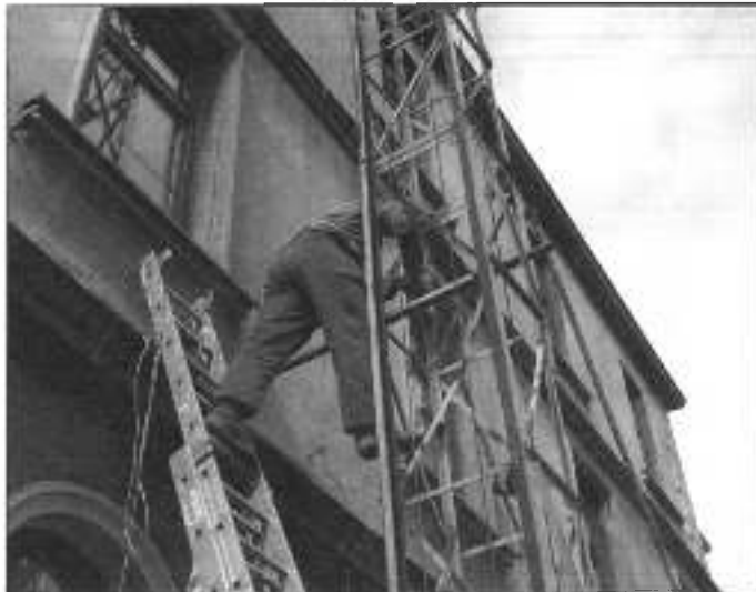
Rozpoczął się remont dachu na ratuszu. Po przetargu do robót przystąpiła firma Famex Bis z Cieszyna. Koszt robót to około 500.000 zł. Dach zostanie wyremontowany do końca lipca. Później planowane jest odnowienie elewacji ratusza. Fot. W. Suchta
