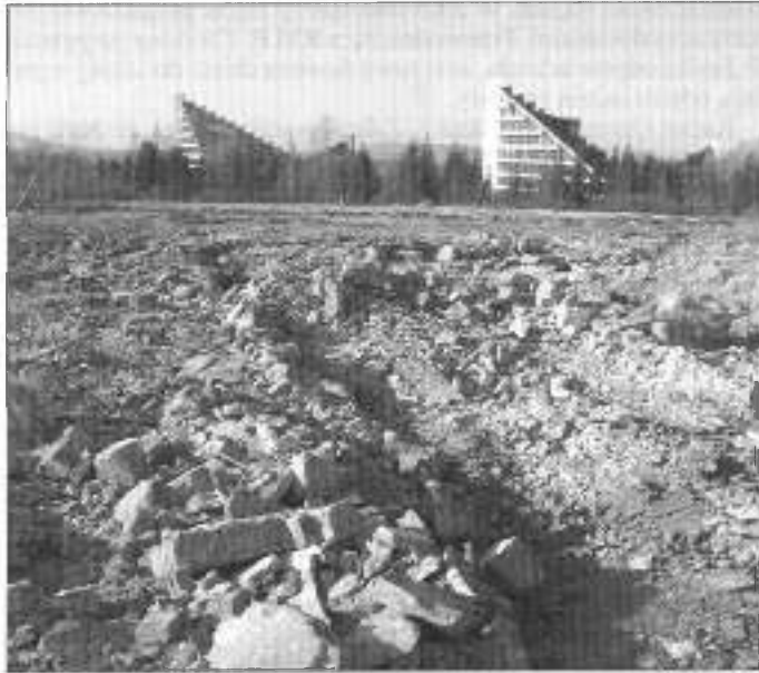
Tak wygląda miejsce po rozebranych barakach na Zawodziu. Prace rozbiórkowe przeprowadzono w grudniu. Fot. W. Suchta
