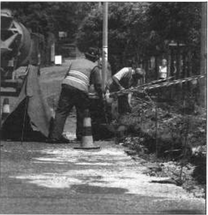
Ulica Grażyńskiego jest drogą powiatową i właśnie doczekaliśmy się jej remontu. Miejmy nadzieję, że to początek, a za nią pójdą ul. Daszyńskiego i Dominikańska. Wzdłuż ulicy wycięto 11 drzew, które przeszkadzały w podniesieniu krawężnika. Gdy to już zostanie zrobione, drogowcy położą nowy asfalt aż do przejazdu kolejowego. Głównym wykonawcą jest firma „Kamil” z Ustronia. Fot. W. Suchta
