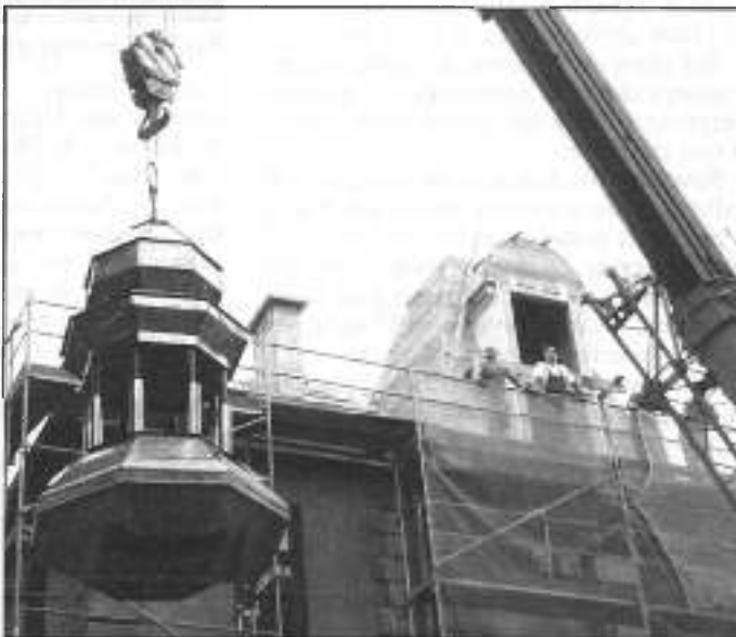
Transport wieży na dach ratusza.
