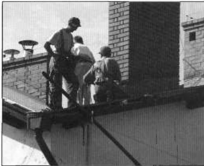
Remont dachu na Gimnazjum nr 1.
