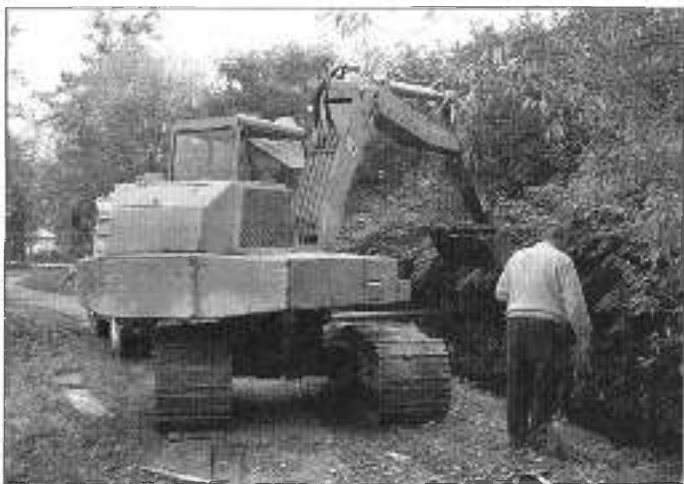
Pogłębianie Młynówki przy ul. Ogrodowej.
