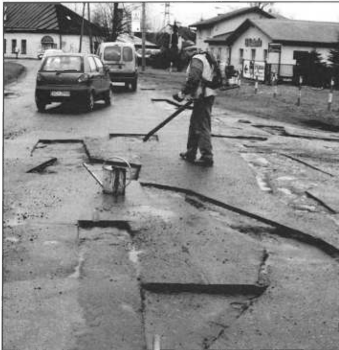
Rozpoczął się remont ulic.
