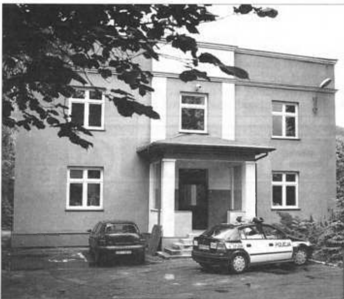
Z zewnątrz komisariat już jak nowy.
