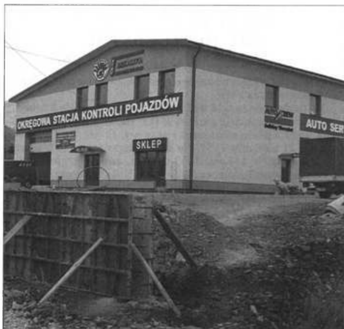
Budynek nowej stacji.
