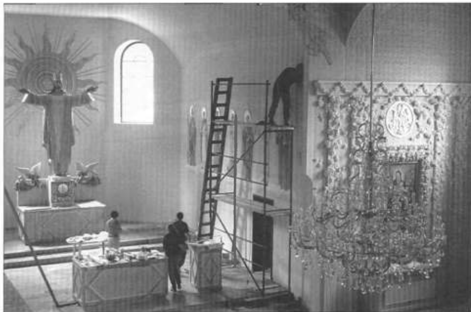
1 września. Trwają prace wykończeniowe wewnątrz świątyni.
