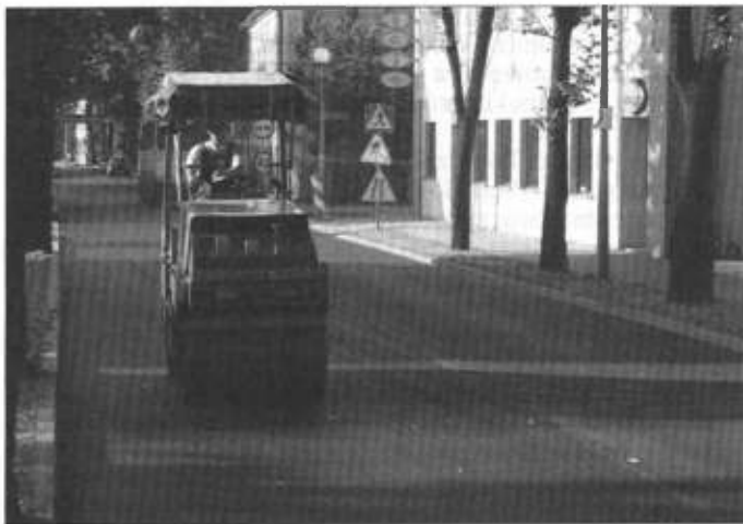
Końcowe prace na ul. 3 Maja.
