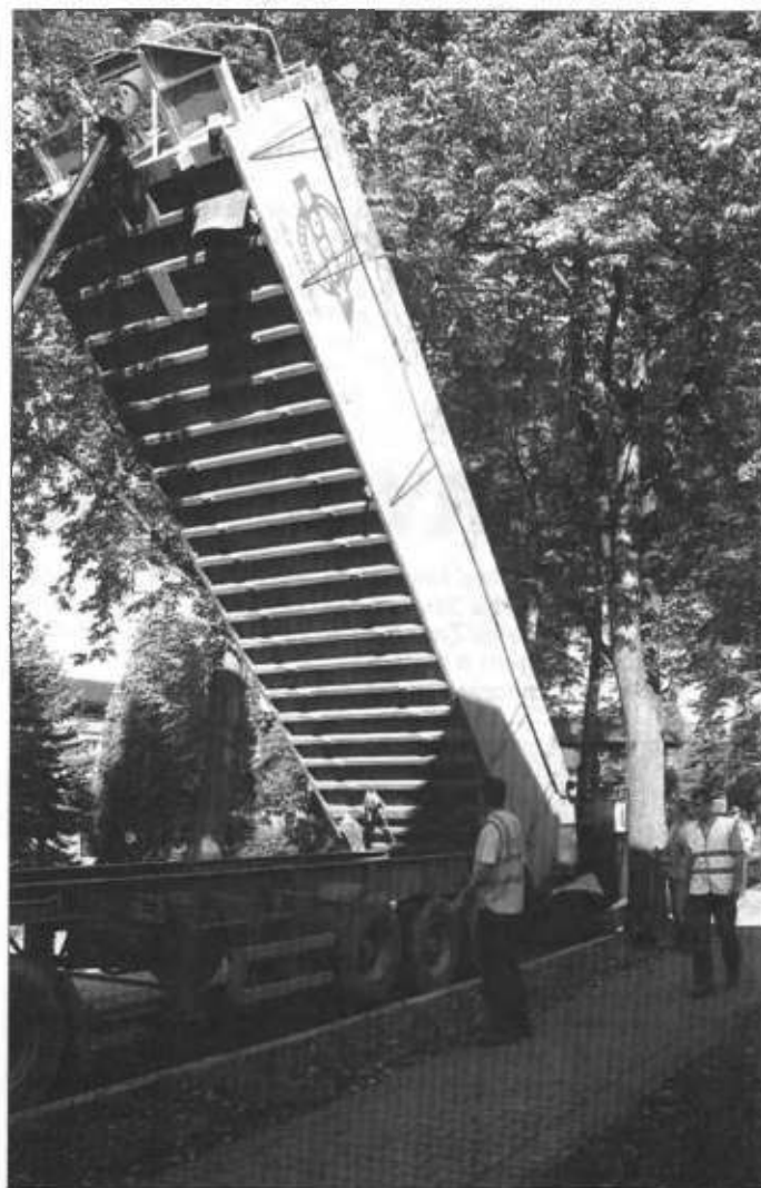
W poniedziałkowy ranek na ul. 3 Maja wylewano kolejną porcję asfaltobetonu. W tym miejscu praca była łatwiejsza, bo odbywała się na odcinku zamkniętym dla ruchu samochodów. Fot. M. Niemiec
