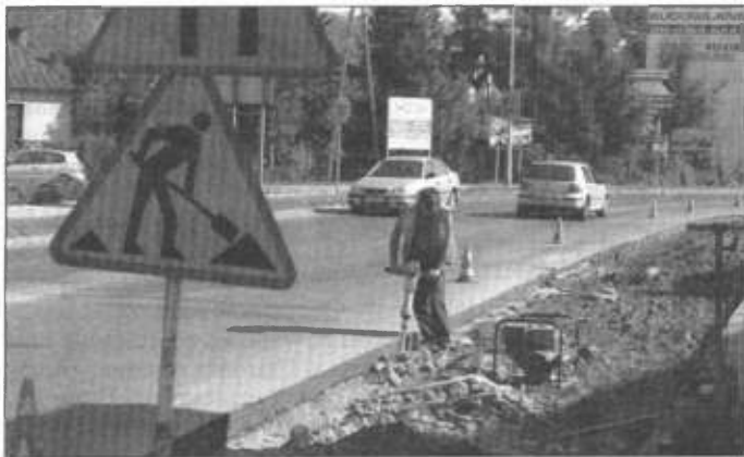
Remont na ul. Daszyńskiego.
