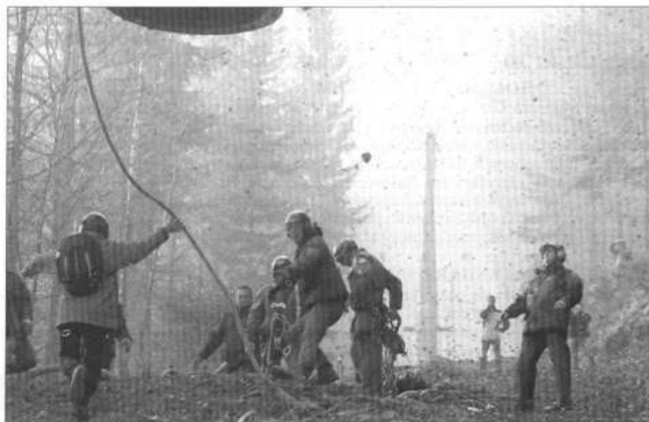
Praca pod helikopterem. Stawianie słupa.
