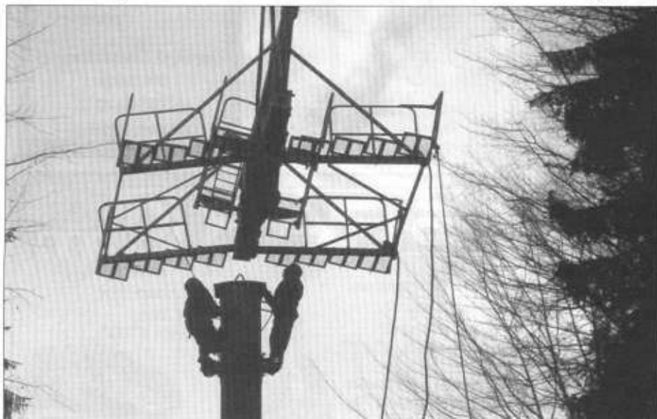
Odbiór kolejnego elementu ze śmigłowca.
