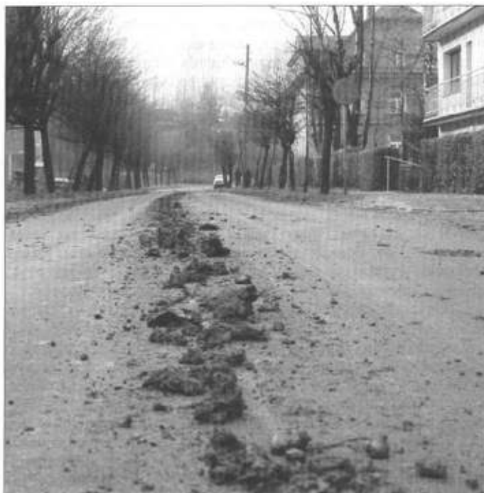
Ślady budowy na ul. Konopnickiej.
