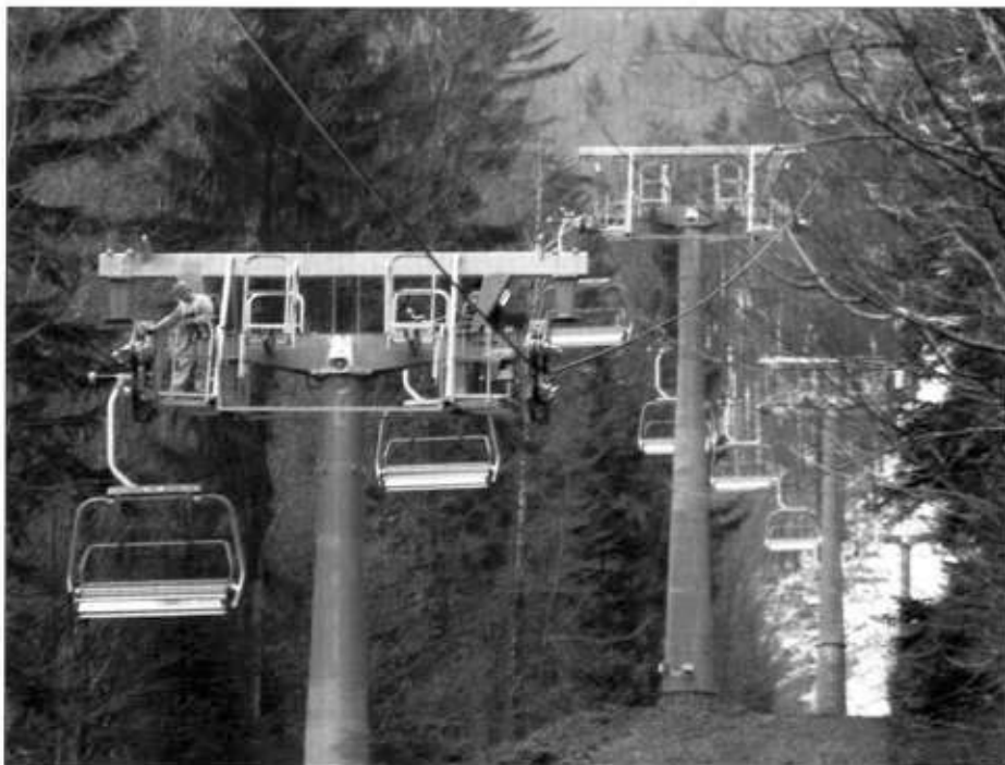
Zamontowano już część krzesełek.
