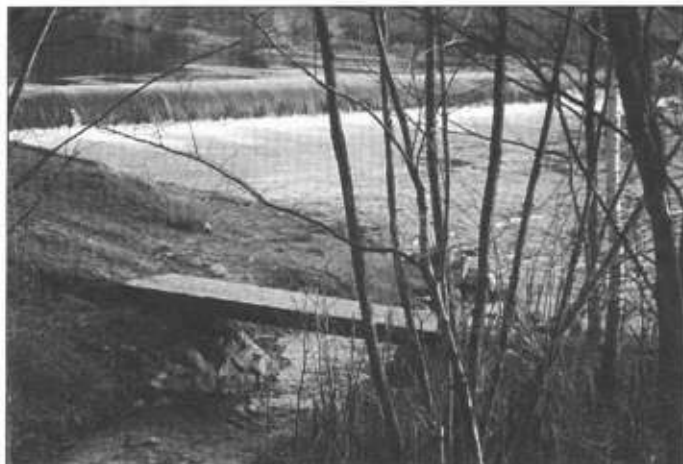
Jest już kładka na Gościradowcu. Swobodnie rowerem można przejechać po prawej stronie Wisły. Fot. W. Suchta
