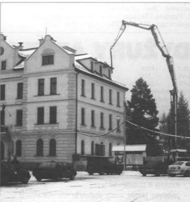
Trwa adaptacja poddasza ratusza. Budowane są schody na poddasze. Na zdjęciu lanie betonu podczas tej operacji. Fot. W. Suchta
