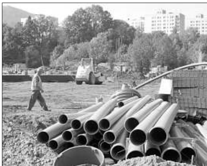
Wre praca na budowie Lidla.
