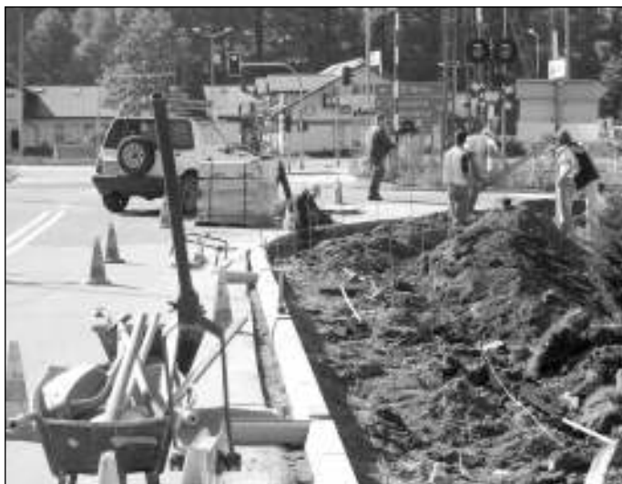
Powstaje chodnik na ul. Wczasowej.
