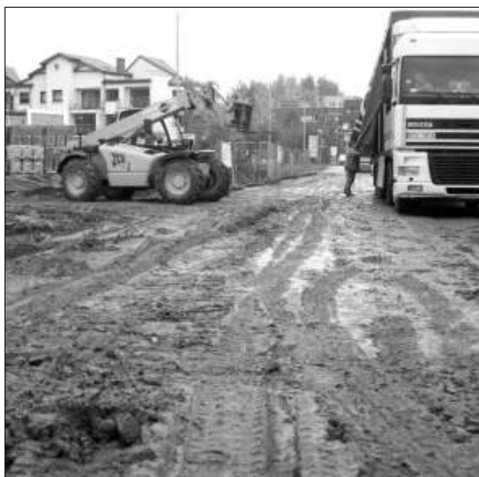
Na ul. ks. Kojzara front robót.
