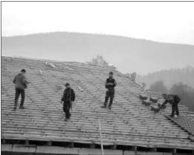
Prace wysokościowe na dachu LIDLA.
