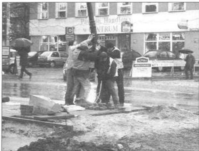
Podczas remontu chodnika na ul. Daszyńskiego w kilku miejscach stawiane są nowe latarnie. Fot. W. Suchta
