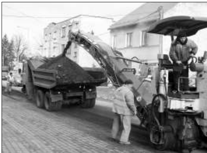
Zdzieranie starego asfaltu na ul. Daszyńskiego. Fot. W. Suchta
