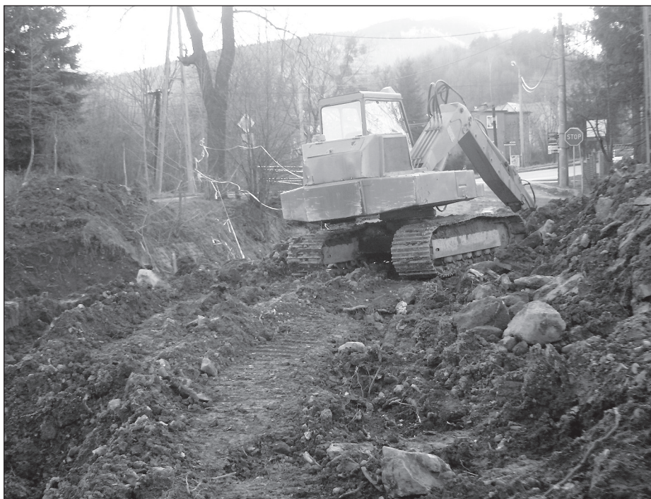
Rozpoczęto budowę drogi pod skarpią.
