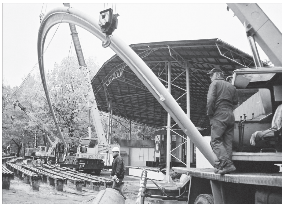
Wiosna 2003. Prace przy zadaszaniu amfiteatru.
