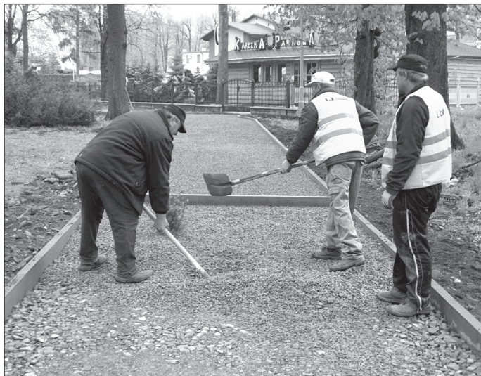
Rozpoczął się remont amfiteatru i jego okolicy. Zaczęto od alejek w Parku Kuracyjnym. Fot. W. Suchta
