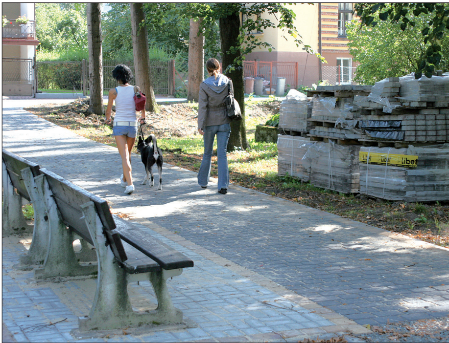
Część alejek już wybrukowano.
