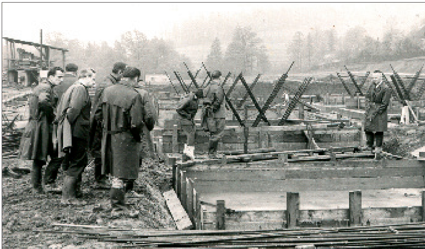
Wiosna 1969. Wykop pod obecne sanatorium Równica. K. Świątek stoi pierwszy z prawej.
