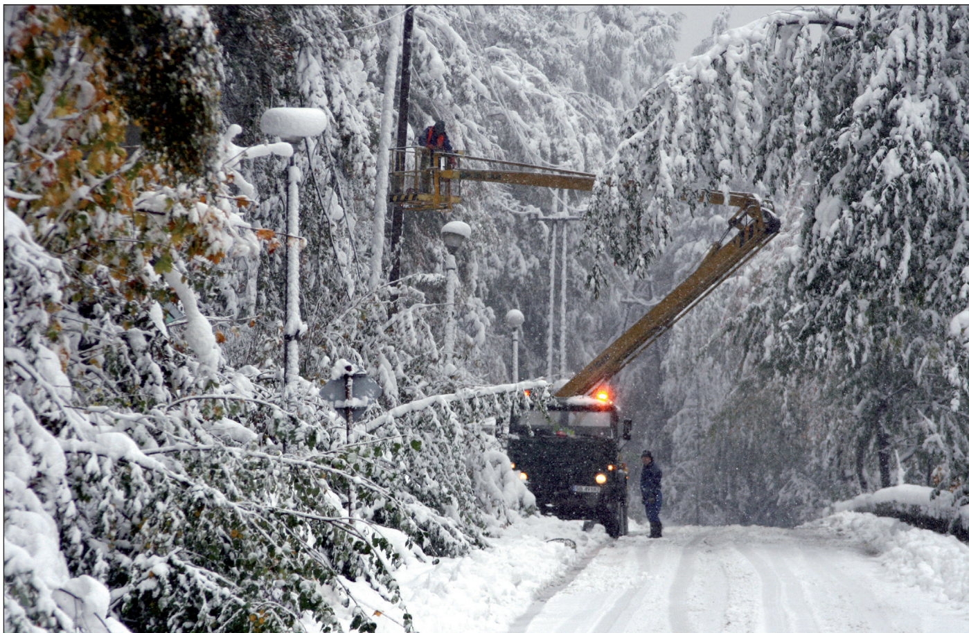
Energetycy w akcji na ul. Turystycznej.
