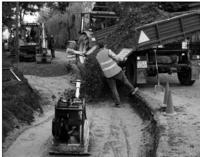
Trwa budowa chodnika na ul. Szerokiej, od ul. Wiejskiej do ul. Kreta. Roboty prowadzą ustroniskie firmy J. Górnioka i P. Szuby. Koszt 240.000 zł. Zakończenie budowy w połowie grudnia. Fot. W. Suchta
