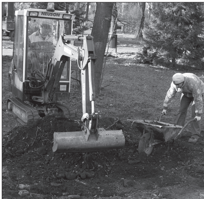
Pogoda sprzyja, więc trwają prace w Parku Kuracyjnym wokół amfiteatru. Fot. W. Suchta
