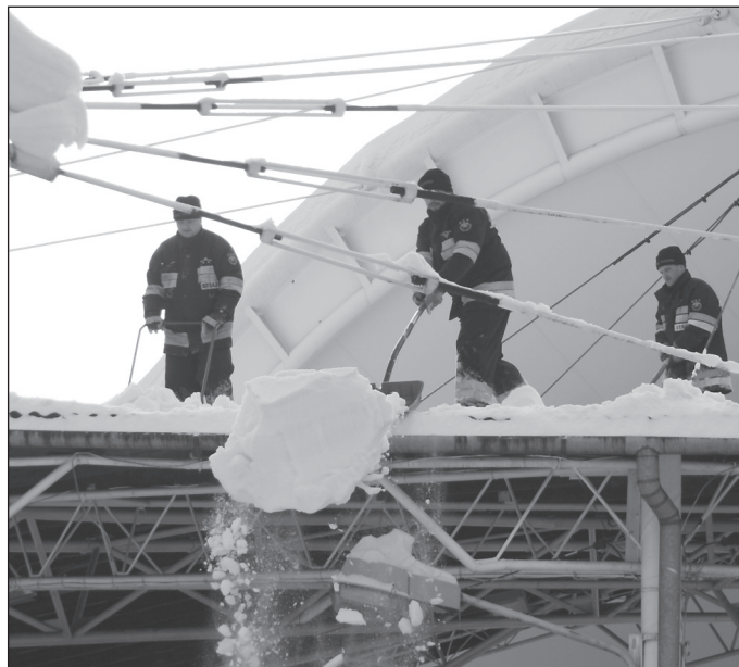
Po obfitych opadach śniegu strażacy mają pełne ręce, a raczej pełne łopaty roboty. Tu ośnieżają dach amfiteatru. Fot. W. Suchta
