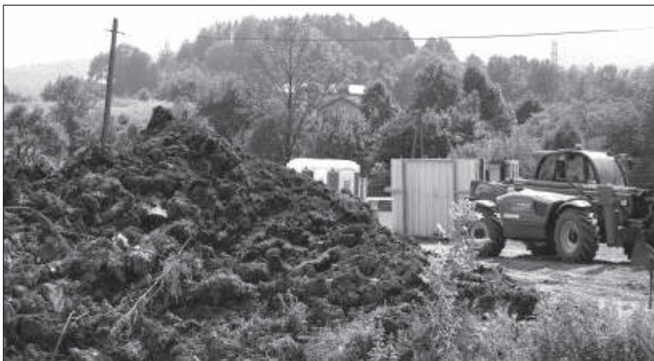
Rozpoczęła się budowa sklepu przy ul. Brody.
