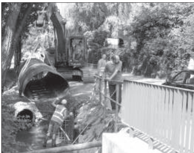
Roboty na ul. A. Brody.
