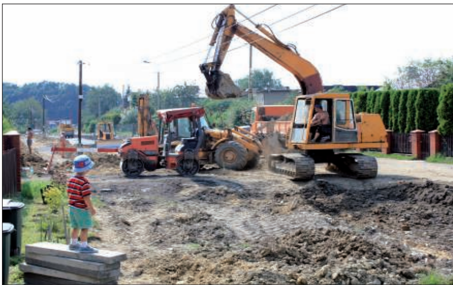
Mieszkańcy bacznie obserwują prace na swojej ulicy.
