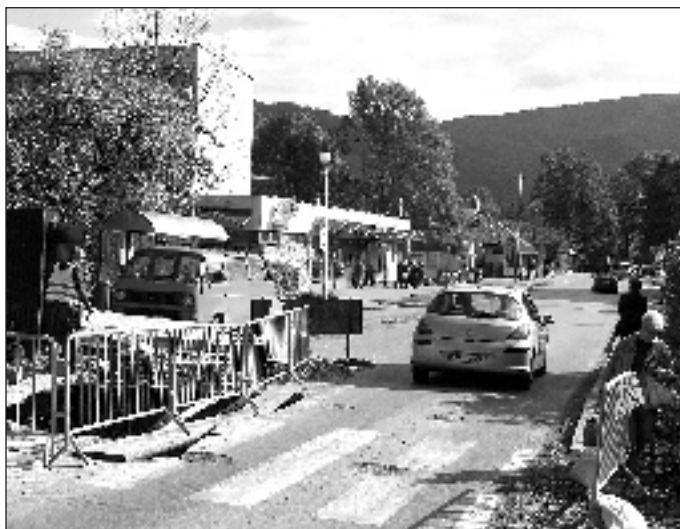
Roboty na ul. Cieszyńskiej.
