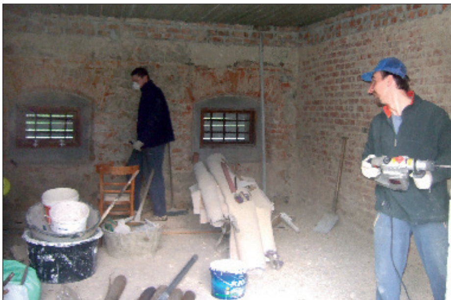
Remont pomieszczeń magazynowych.
